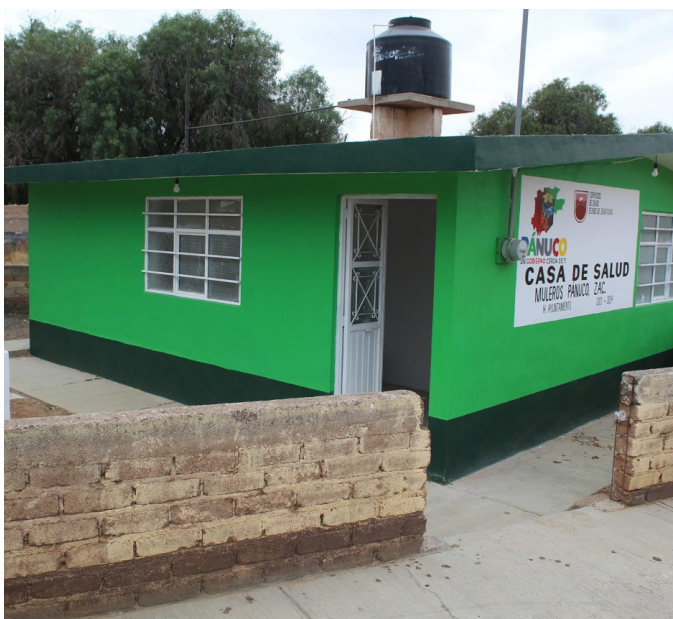
Rehabilitación de la Casa de Salud en la localidad Muleros
