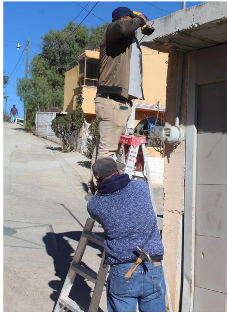
Colocación de nomenclatura en la cabecera
